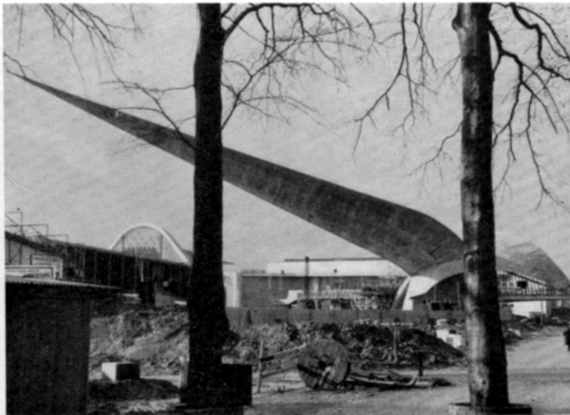
Fig. 45. — Vue d'ensemble de la construction après démontage des échafaudages.
