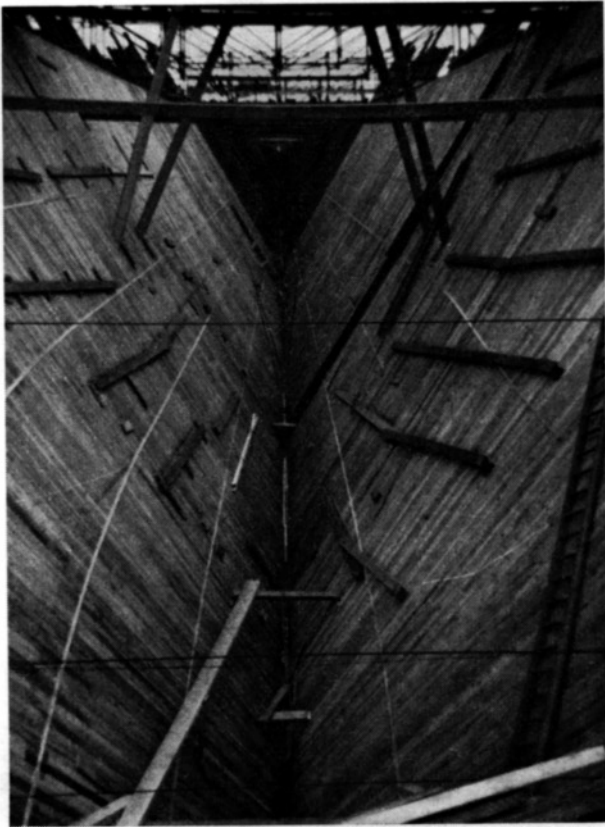
Fig. 29. — Vue intérieure du coffrage de la flèche.
