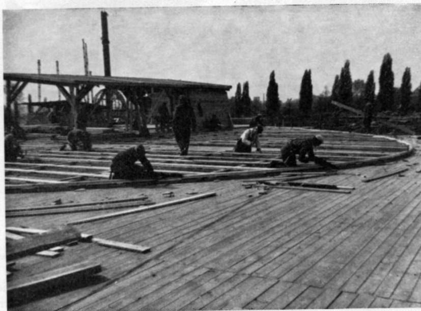
Fig. 25. — Plancher de traçage — Préparation des gabarits de la coupole.
